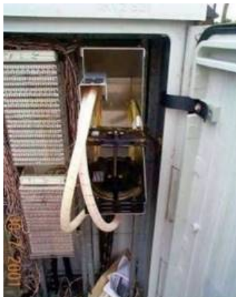
Abbildung 63: RXS-EVs verbaut in Cu-KVz (Gehäuse 82)
