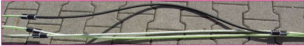
Abbildung 37: Montiertes PPWR-t 12 und SNR12 vor E&MMS Muffe
